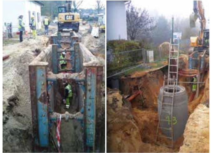
Travaux rue Larroze : pose du réseau jusqu'à 3m de profondeur
