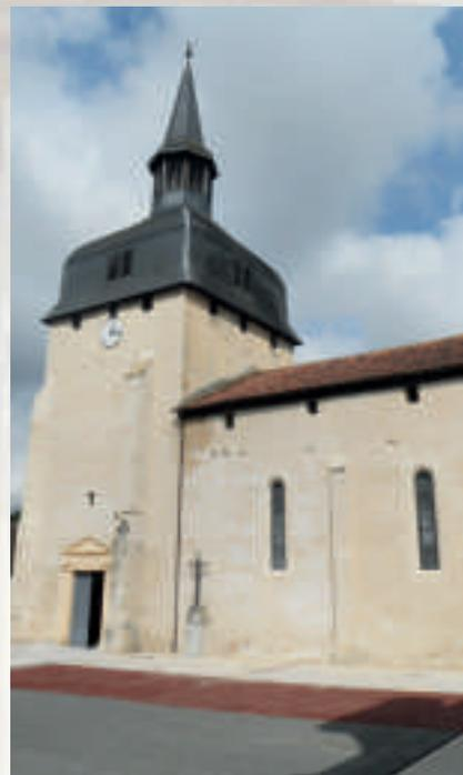
luche - et à traiter le clocher de manière différenciée - car bâti en moellons de Bidache par un chaulage semblable aux traces de badigeon clair retrouvées sous l'enduit avant travaux.
